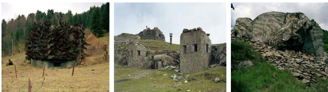
Imágenes de Búnkeres suizos camuflados como un bosque, unas ruinas, y unas rocas Foto: Leo Fabrizio (1999-2004)
